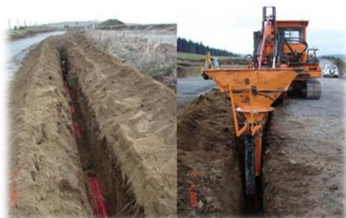
Figure 13 : Réalisation de la tranchée et de la pose du câble
